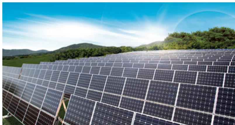
▲현대에너지솔루션 태양광 설치 모습
